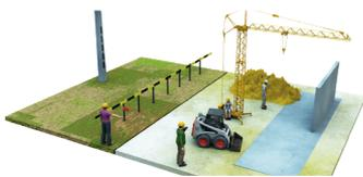
Pour déplacer, nettoyer une canalisation électrique enterrée ou ouvrir un fourreau, il est nécessaire de disposer de l'habilitation électrique **BF/HF**
