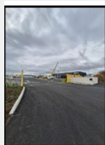
Entrée du site
