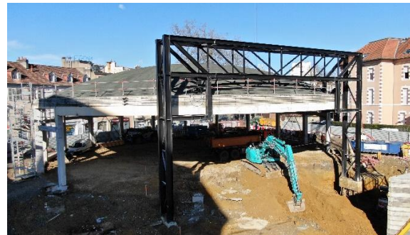
Le Foirail de Pau après démolition et suppression des deux poteaux béton (ouverture du cadre de scène)
